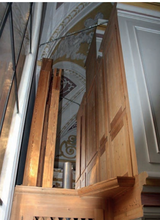
Rückwärtiger Zugang zum Schwellwerk – ohne absichernde Geländer
