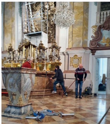
Die Arbeiten beginnen
